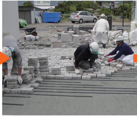
ガイドレール敷設
