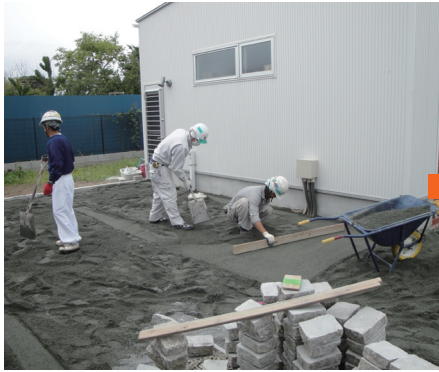
敷砂転圧・高さ調整
