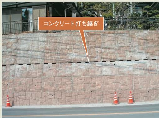
上部にコンクリートを打ち継ぐ場合、上部コンクリートが漏れて下部のカラー転写表面にセメントが付着する場合があります。
