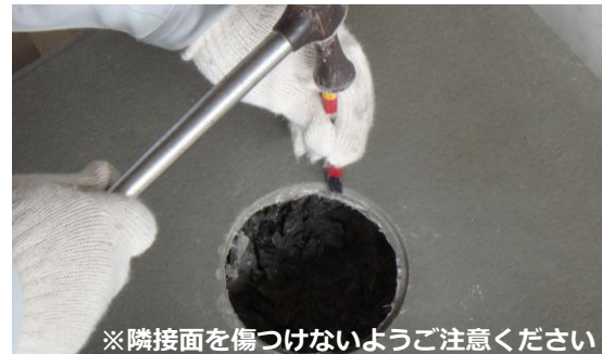
排水孔周辺はタガネを使用すると綺麗に仕上がります
