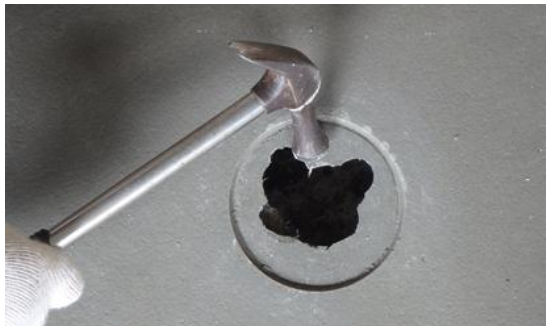
中央の排水孔部薄板をハンマーで打ち抜きます
