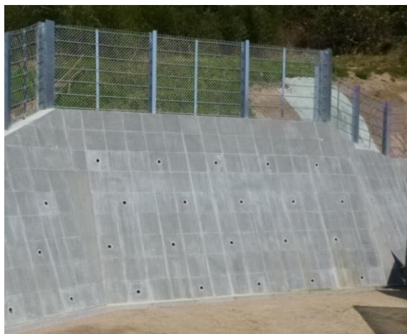
施工イメージ①
