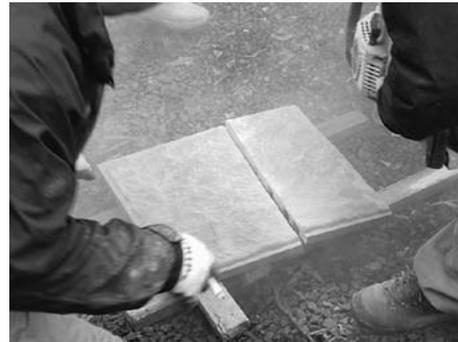
切断後の型枠パネル
