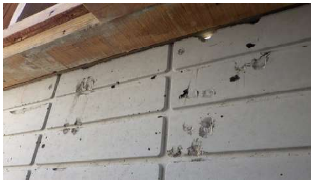
<欠け> 脱型時のパールによるもの。 上端によく見られる。
