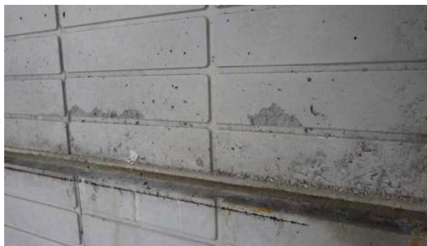
<欠け> 無理な脱型によるもの。 下端の方によく見られる。
