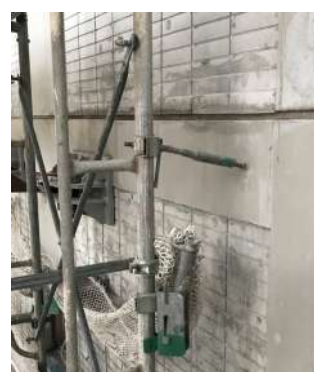
<壁つなぎ施工写真② フラット面>
