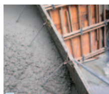
4 コンクリート打設
