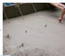
5 次のリフト用のアンカー筋準備
