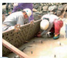
2 型枠パネル1段目の組立
