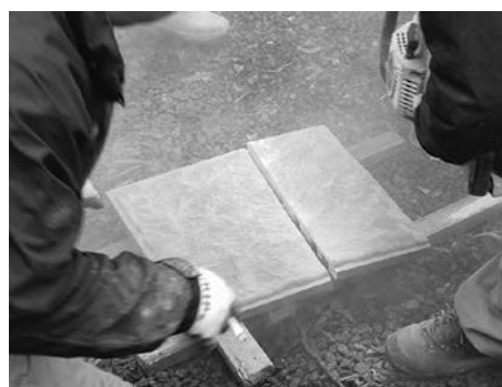
切断後の型枠パネル
