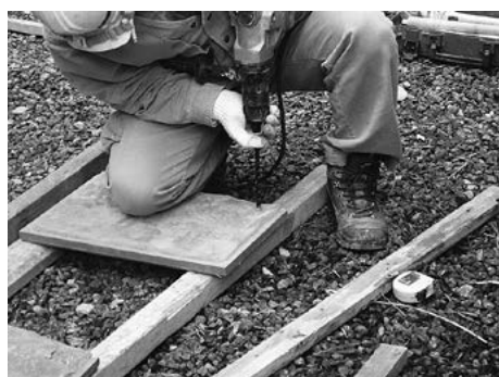
\phi 10.5\text{mm} ドリル刃使用 ヒザつき姿勢
